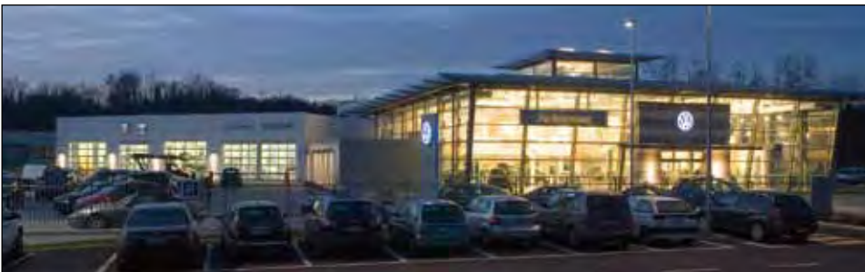
Neues Autohaus von Autoarona in Paruzzaro: Eine KNX Visualisierung führt die Gebäudetechnik von drei Standorten des Autohändlers zusammen.
