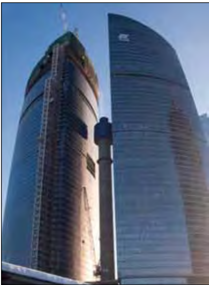
Auf 33 Etagen des „Zapad“ werden in den Räumen der VTB Bank Funktionen der Gebäudetechnik mit KNX gesteuert.
